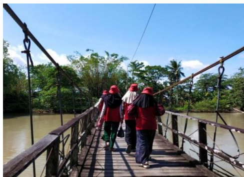
Gambar 1. Jembatan Desa Abbanuangge
