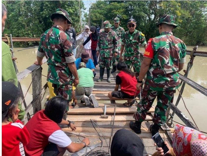
Gambar 5. Proses Pemeliharaan Jembatan Abbanuangnge
